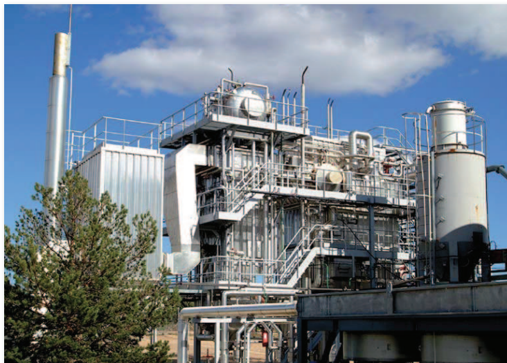
Figura 8. Izquierda: Diagrama de flujo de un filtro de mangas para la retención de partículas en una corriente de gas. Derecha: Caldera de lecho fluidizado de 3,5 MWt con filtro de mangas en CEDER-CIEMAT, Soria.
